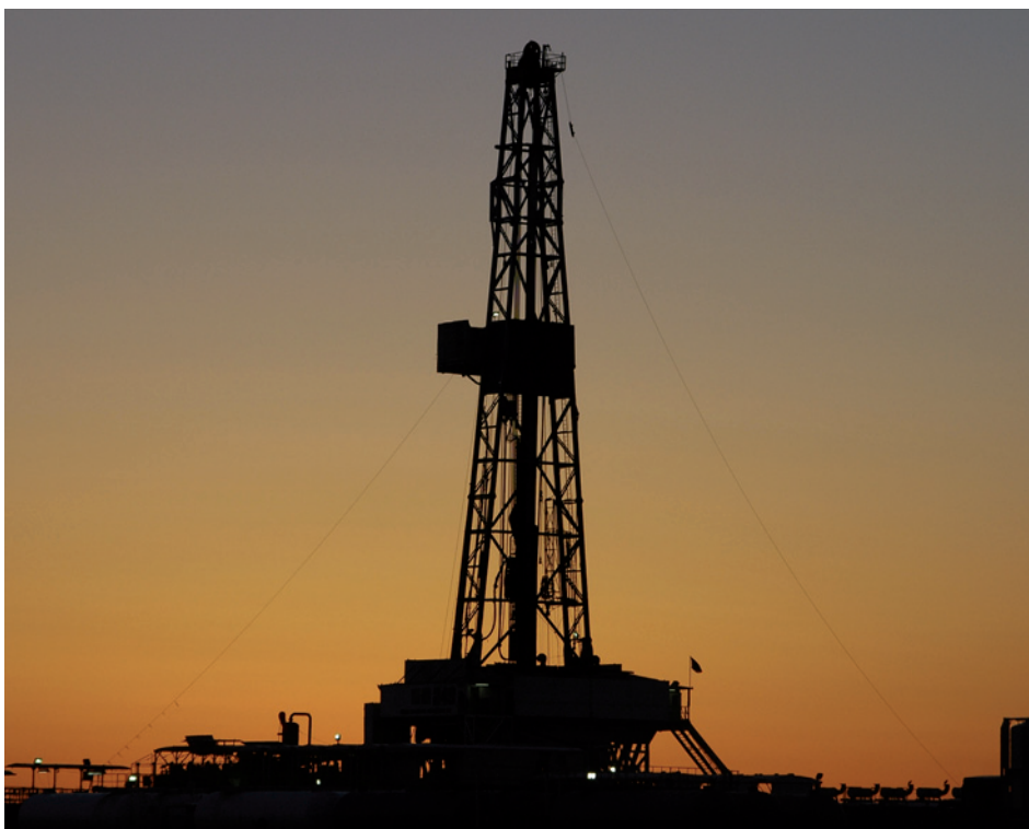
Ölbohrtürme (auch Tieftemperatur-Anwendungen)
